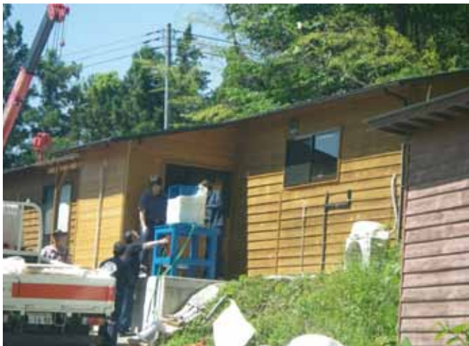
クレーン車で鉛遮蔽体を設置
