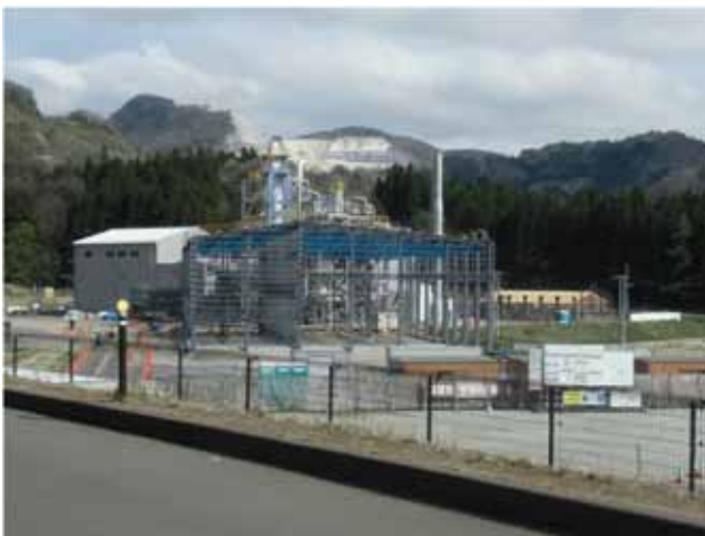
現地では建設が進んでいる 田村バイオマス発電
