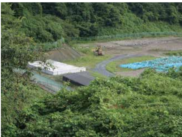
一関市舞川最終処分場の高濃度汚染焼却灰保管状況（コンクリートと黒シートの部分）
